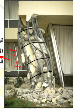
انهيار العمود وفق ميكانيزم الانهيار الطائفي وعدم صحة تصميم العمود على القص
