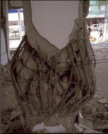
الشكل (3-5) انهيار العمود في مكان
